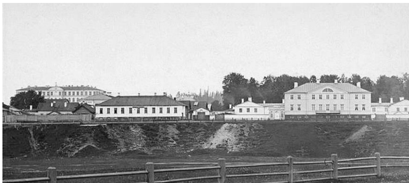
Дом горного начальника на фотографии Я. Пекарского. 1884 г. Слева – тамбур входа в здание. На втором этаже (первом жилом) – балкон гостиной. За домом – высокие деревья сада и естественного соснового древостоя, сохранявшегося до последней трети XX в.
